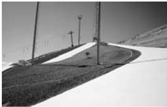
Las obras, casi concluidas, están paradas por un recurso de ecologistas
